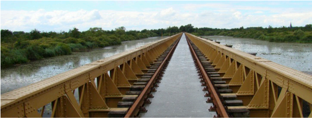
Spoorbrug in Moerputten
