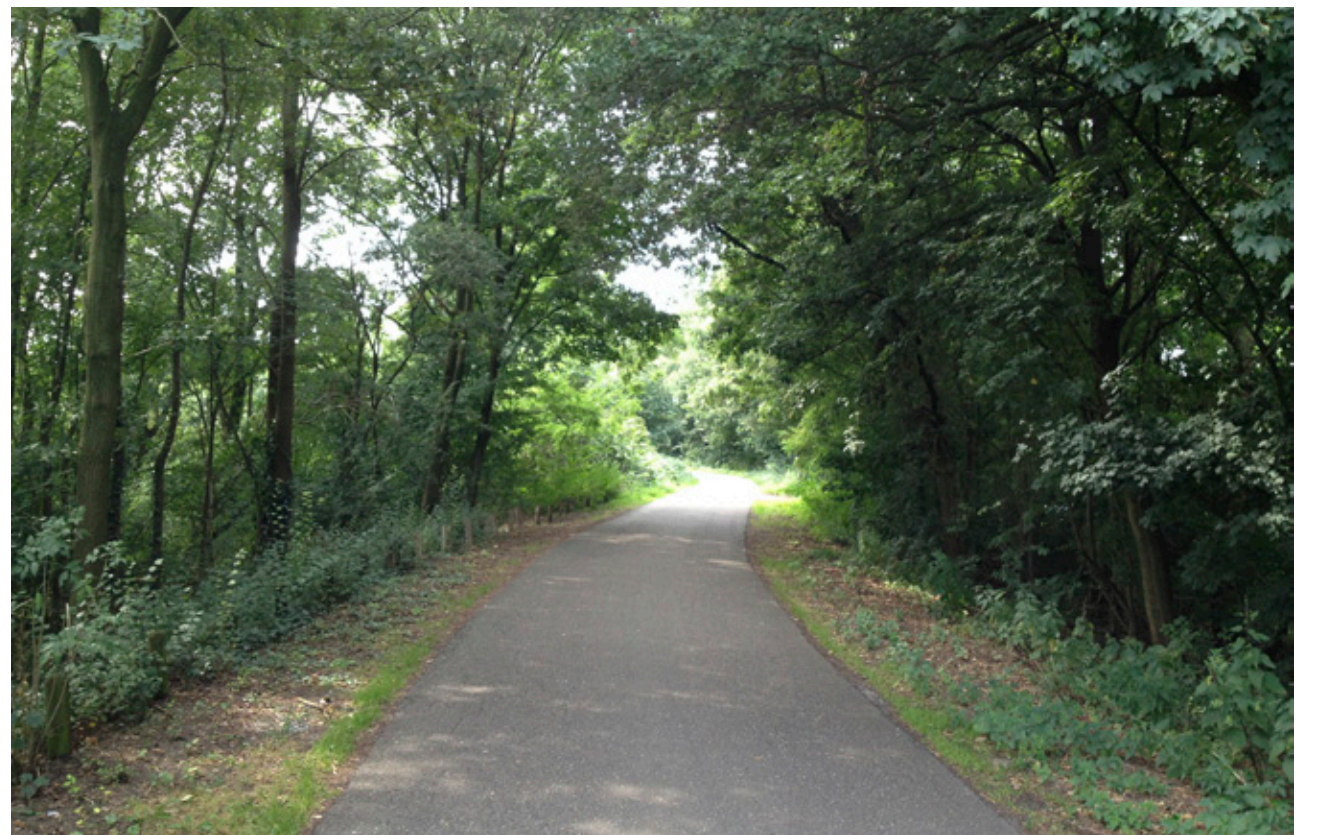
29 De Heinisdijk was onderdeel van de Linie en is, hetzij enigszins aangepast, nog zichtbaar
